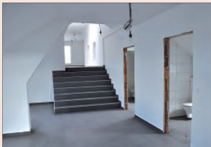
Im Vorraum wurden Fliesen verlegt.
