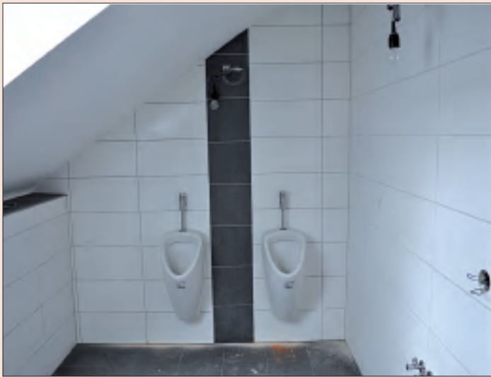
Sanitärinstallationen in den Toiletten.
