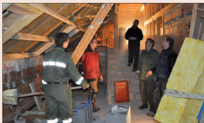
Abbrucharbeiten im Vorraum
