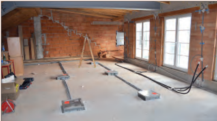
Verlegen der Heizungs- und Elektroleitungen
