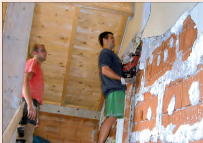
Abbrucharbeiten der alten Fassade im Stiegenhaus
