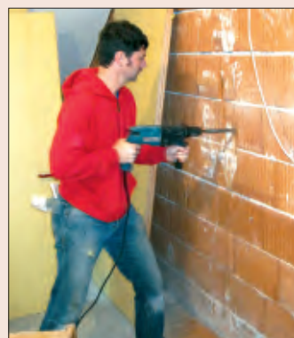
Vorbereitungen für die folgenden Aufmauerungsarbeiten
