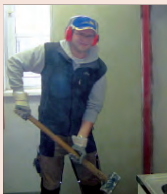
Abbrucharbeiten zur Erweiterung der bestehenden Atemschutzwerkstatt
