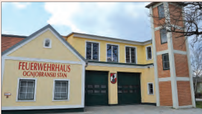
Instandsetzung der Fassade am Feuerwehrhaus
