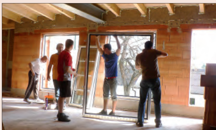
Fenstermontage im Feuerwehrhaus
